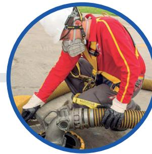
13. Verificar que no haya fuentes de ignición cercanas, la hermeticidad en todas las conexiones de la manguera de descargue y los boquereles (del carrotanque y del tanque de recibo), para que no se presenten goteos de combustible.
